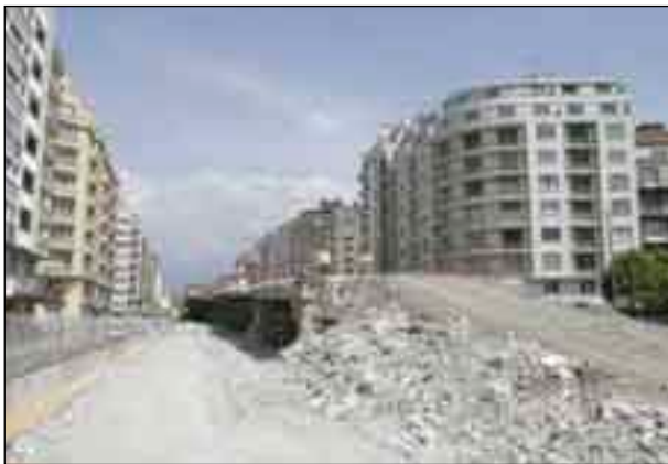
Een sterke actie was het afbreken van het viaduct op het kruispunt van de grootste boulevards van Grenoble.
